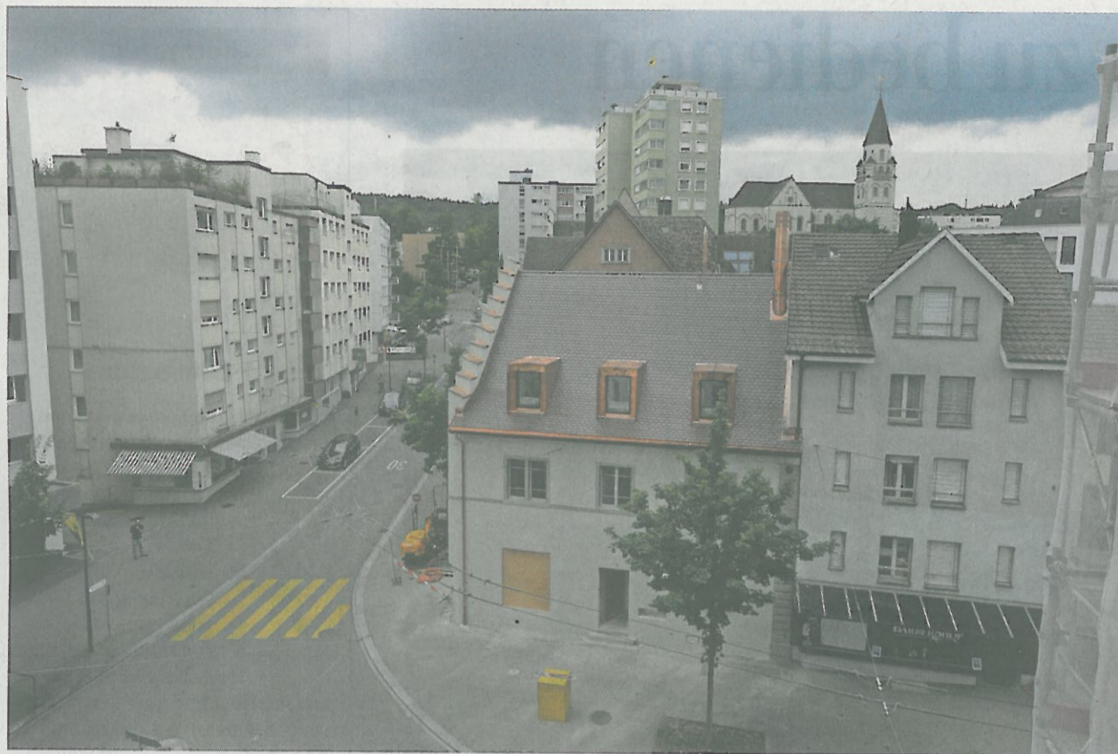
Neues Dach und neuer Anstrich: Das Chübelimoserhaus im Zentrum Neuhausens macht von aussen wieder einen frischen Eindruck. Im September soll die Sanierung beendet sein und im Erdgeschoss eine Gasthausbrauerei eröffnet werden. Bilder Selwyn Hoffmann
